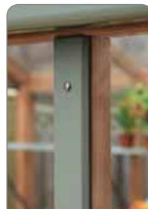
Lattes de recouvrement en aluminium
